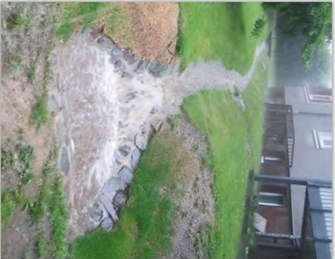
Versickerungsmulde bei Starkregen in Solingen © Kopperschmidt
