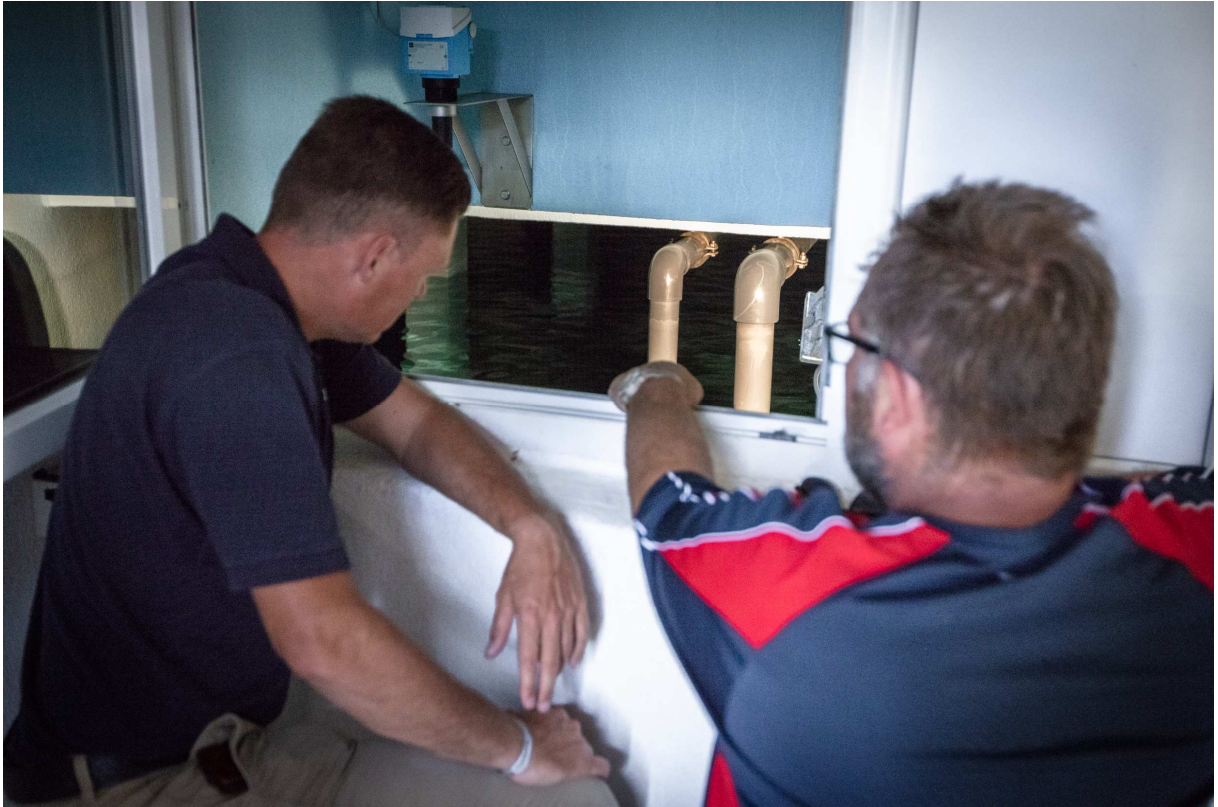
Wassermeister Christian Schäfer (rechts) erläutert Bürgermeister Wilhelm Gebhard die aktuelle Lage der Wasserversorgung in Wanfried. Bild: Christoph Braun
