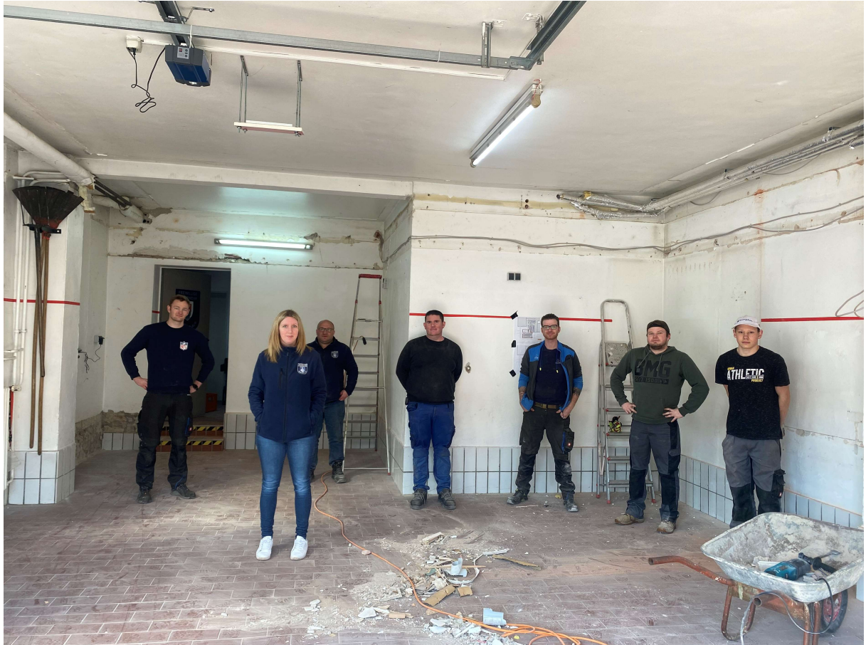
Bild 2: Kameradinnen und Kameraden der Feuerwehr Aue bereiten momentan alles für den Beginn der Rohbauarbeiten vor.
