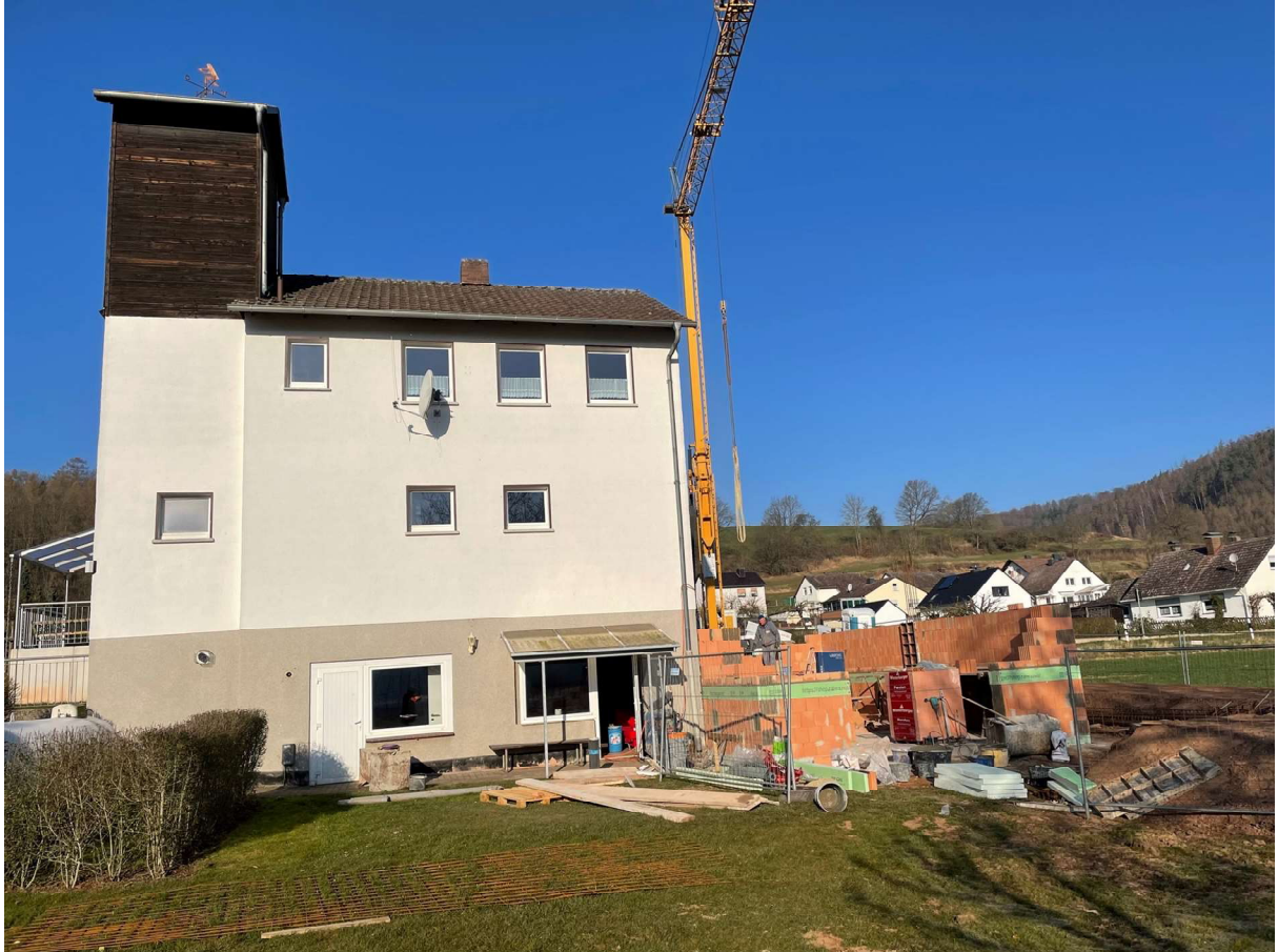
Bild 1: In Völkershausen haben die Rohbauarbeiten bereits begonnen.
